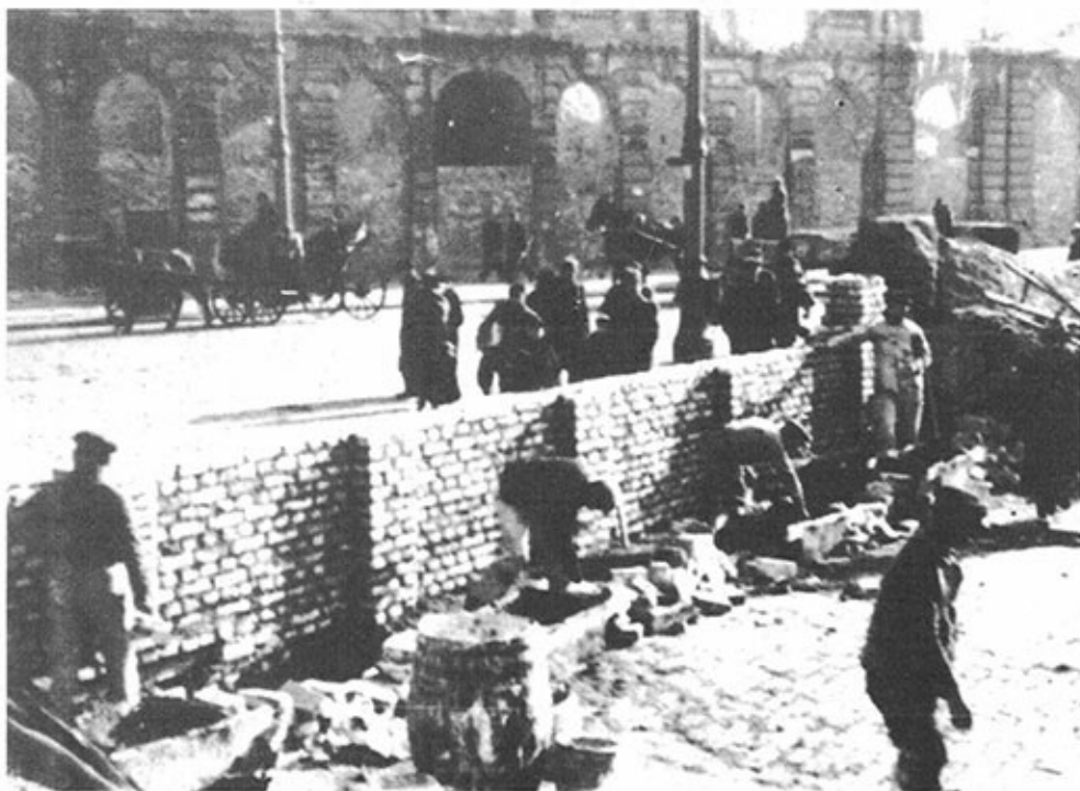
Construcción del muro en la primavera de 1940
